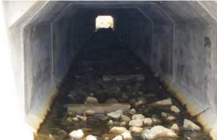
Abbildung 17: Sohlgestaltung im Durchlass mit Geröll und Kies. Quelle: H.-Diel (GFG GmbH)
