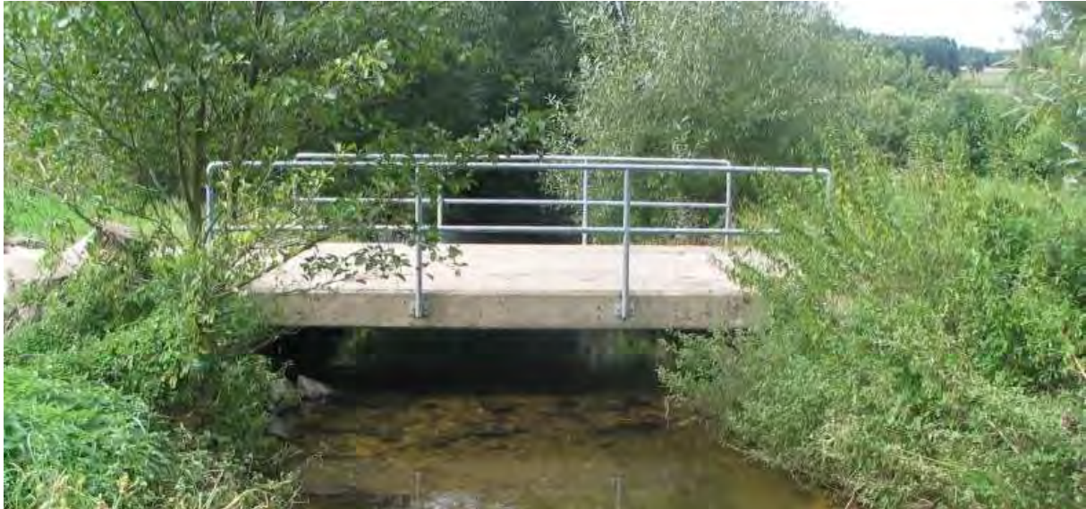
Abbildung 15: Ausführungsbeispiel einer Plattenbrücke. Quelle: https://www.gfg-forbildung.de
