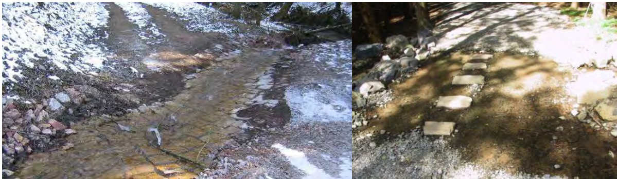
Abbildung 16: Ausführungsbeispiel für Furten. Links grob verlegte Steine, rechts einzelne Trittsteine. Quellen: T. Kowalke, Gerhard Schlösser
