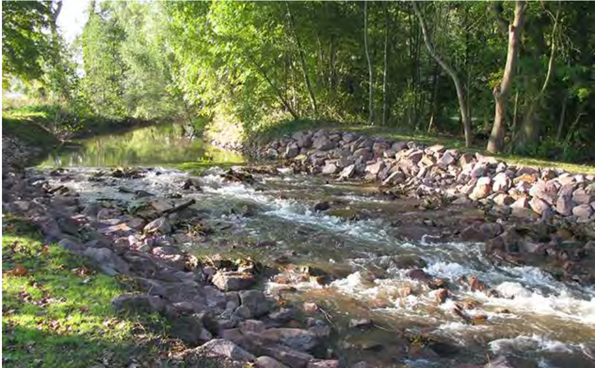
Abbildung 12: Beispiel Sohlgleite mit Niedrigwasserrinne als punktuelle Maßnahmenvariante
