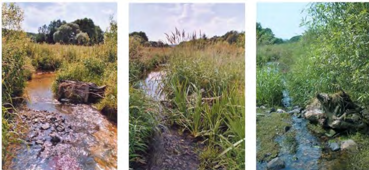
Abbildung 23: Erhöhung der Strömungsdiversität durch Einbringung von Strukturelementen [12]
