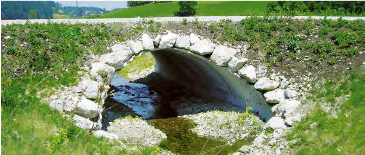
Abbildung 14: Ausführungsbeispiel Maulprofilrohr. Quelle: sytec.ch
